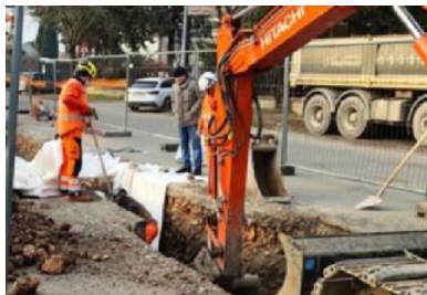
Il cantiere Ruspe in via Palustrella per la connessione delle reti
