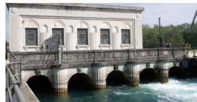
La diga sul canale Virgilio a Salionze paese delle acque
