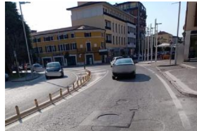
Via XXV Aprile è tra le strade da asfaltare
