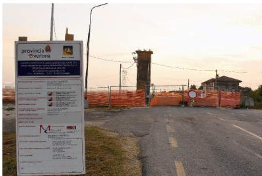
Strada bloccata Il cantiere allestito sulla Provinciale per costruire il ponte DIENNE
