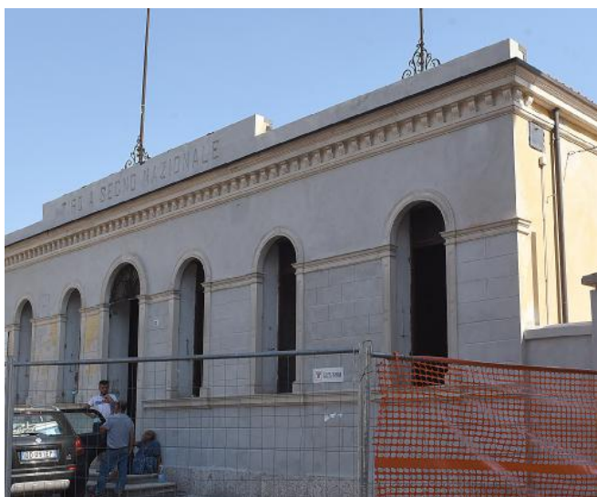
Ex Tiro a segno L'edificio ora è al grezzo e dovrà essere terminato
